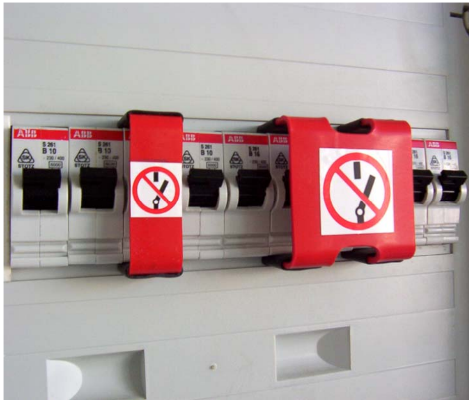
Bild: Sperrelemente beugen wirksam unbefugtem Wiedereinschalten vor.
